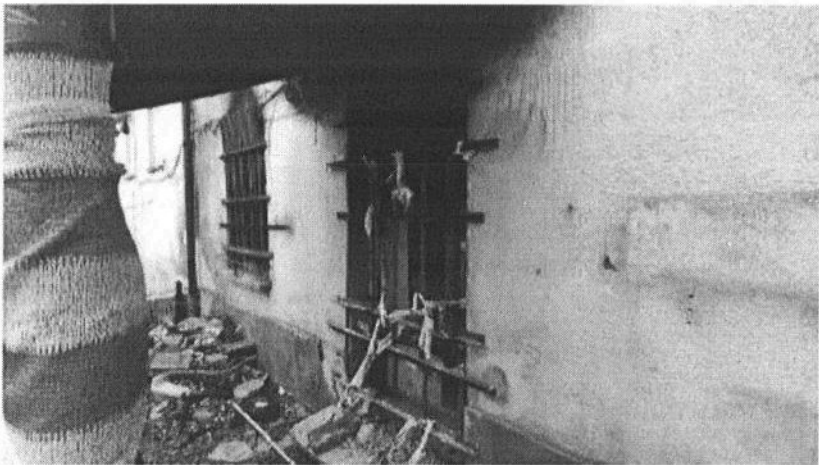
FOTO 11. Cegado y cierre de la puerta de acceso al local de la planta baja.
