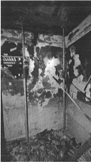
FOFO 7. Apuntalamiento del forjado de hormigón en habitación.
