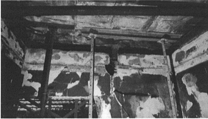
FOFO 6. Apuntalamiento del forjado de hormigón bajo la terraza lado sur.
