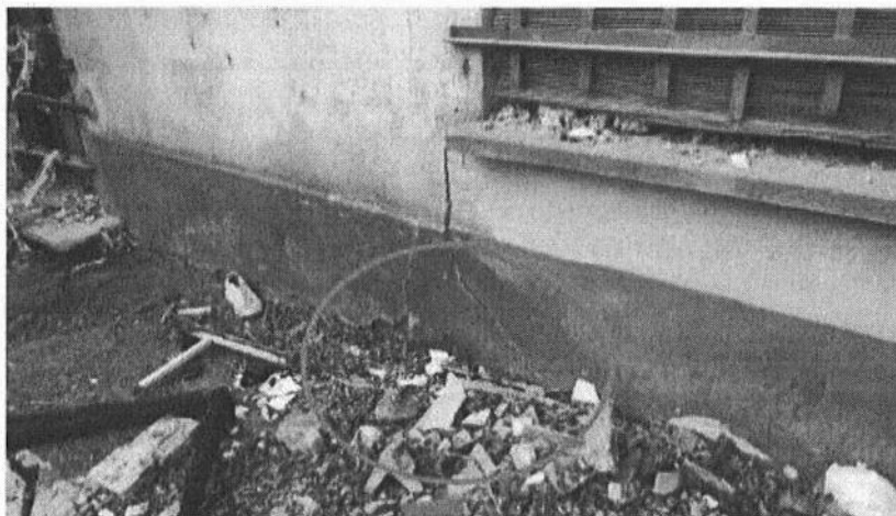
FOTO 3. Zona de recogida de la "Muestra Ventana (Fachada)"
